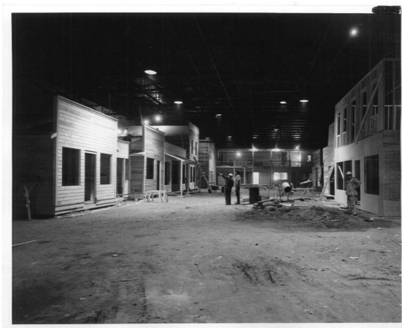
Construction du WDM de Saskatoon, le 18 février 1972
